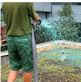
ND Hydroseeder - Mulchschicht über Sedumsprossen sprühen
